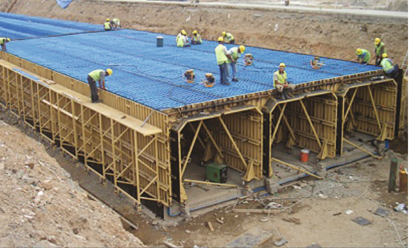
Cidde Altyapı İnşaatı - STFA & Alvan İnşaat Ortaklığı / Suudi Arabistan
