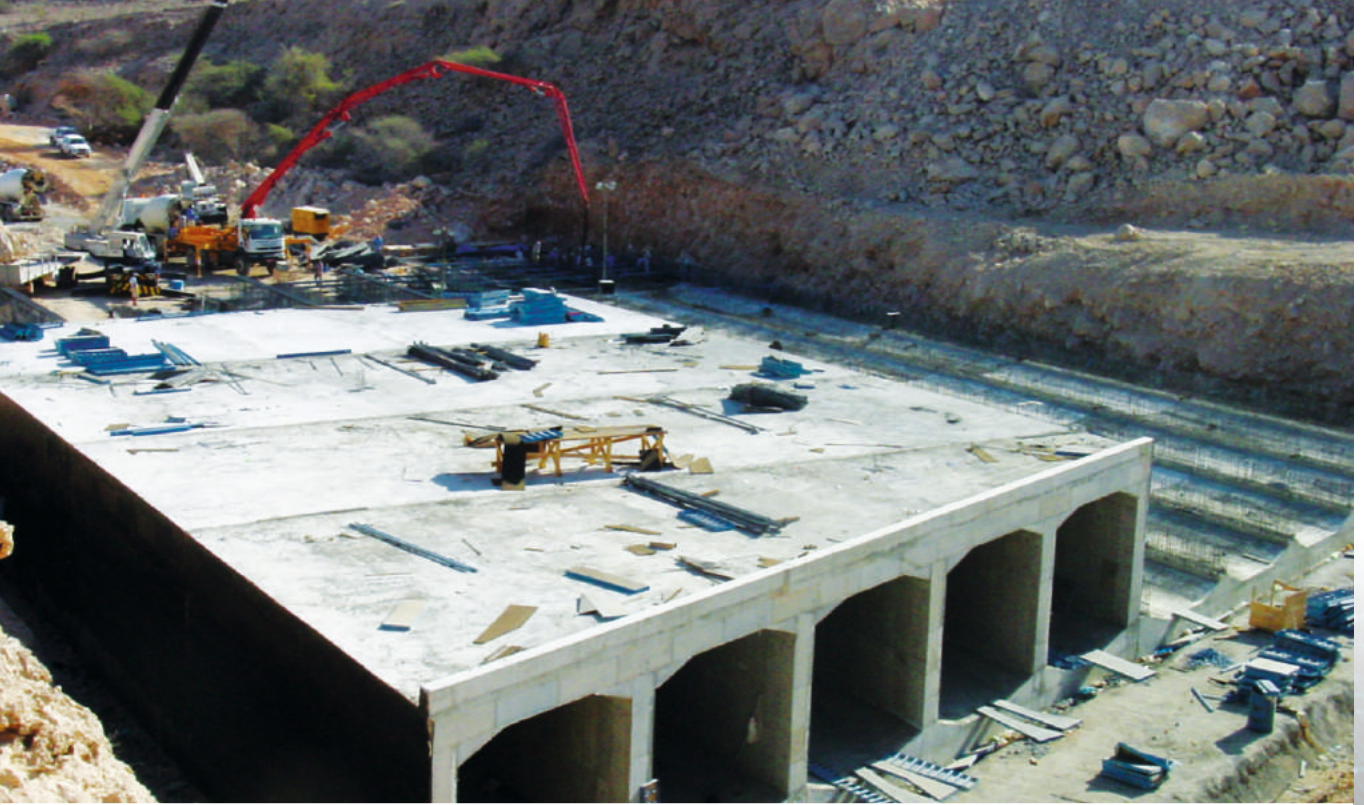
Cidde Altyapı İnşaatı - STFA & Alvan İnşaat Ortaklığı / Suudi Arabistan
