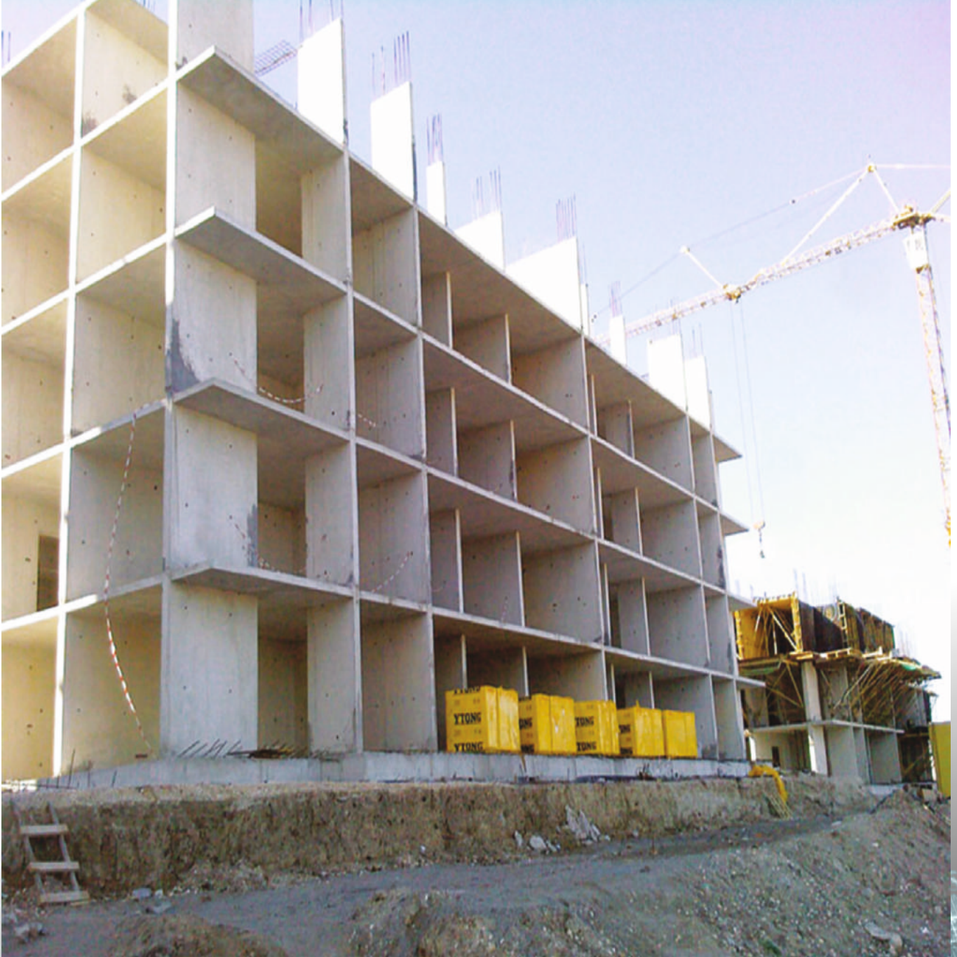
Geçitpark Rezidans İnşaatı - Eren & Begüm Ortaklığı / Bursa - TÜRKİYE
